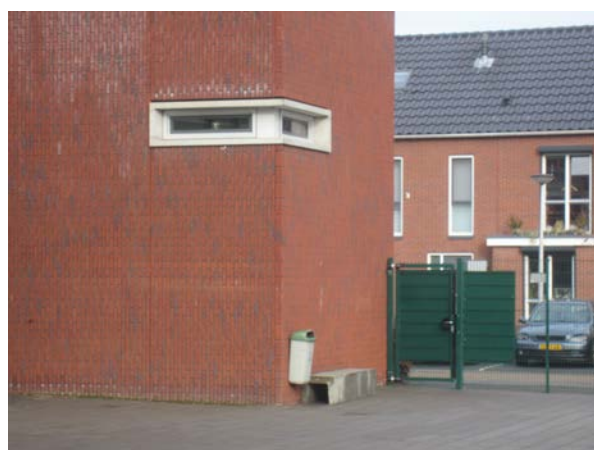
Afvalbakken tegen de gevel. Verwijderen of plaatsen op 5 meter afstand van de gevel.
